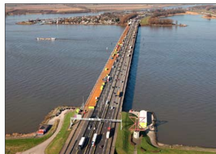
De Moerdijkbrug met de nieuwe slijtlaag.
